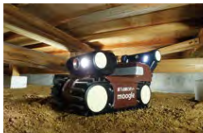
床下を点検走行するmoogle
